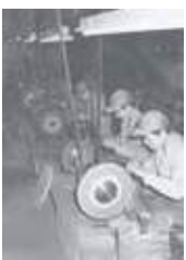
当時の作業現場
